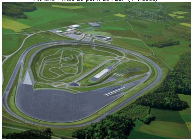
Circuit de développement Bosch à Boxberg, Allemagne
